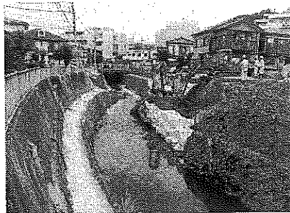
復旧進む大岡川現場（6月20日現在）
